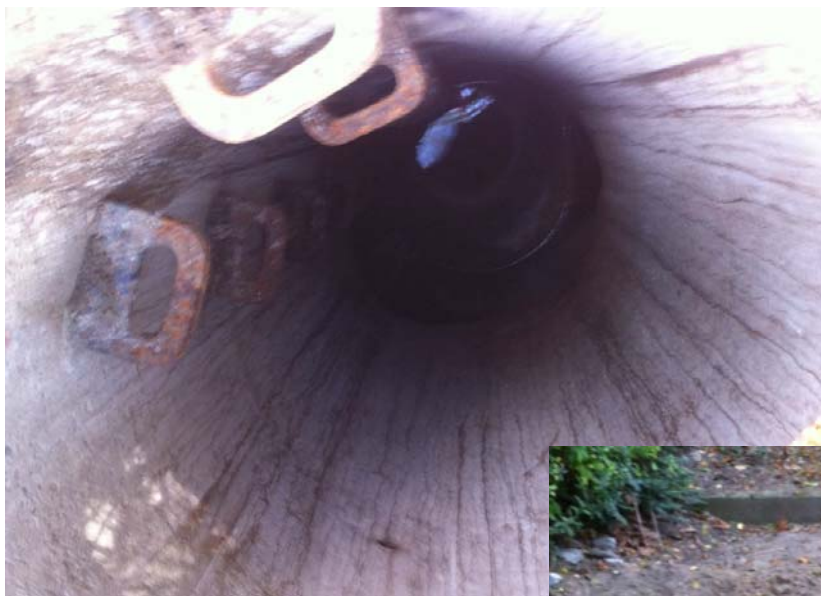
Færdigstøbt med ny brøndring
