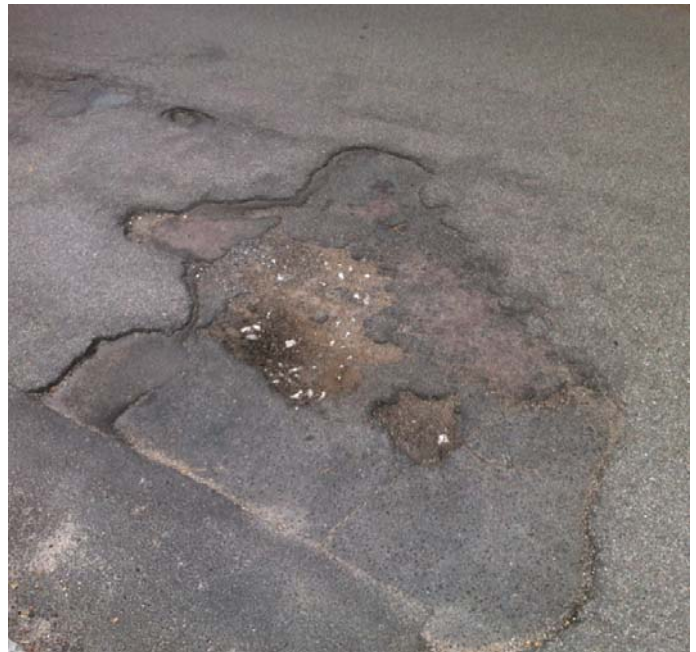
Reparation af asfalten
