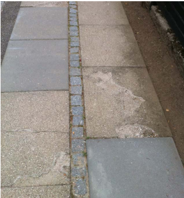
Reparation af asfalten
